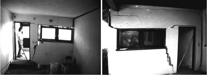
Abbildung 3 Fehlende Fundamentplatte
